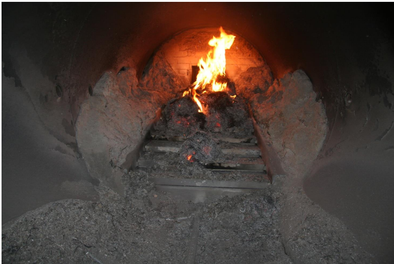
Joonis 25. Dansstokeri kolle - põhjaks on liikuv mehaaniline rest, külgedel olevatest avadest lastakse surveõhk pauguga koldesse. Kolde suudmest toimub tuha ärastus [autori erakogu]
