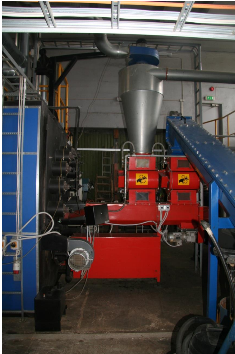
Joonis 24. Kolde tigusöötjasse jõuavad nii hake (mööda sinist konveieri kanalit) ja hein (mööda pneuma transporti ülevalt) [autori erakogu]
