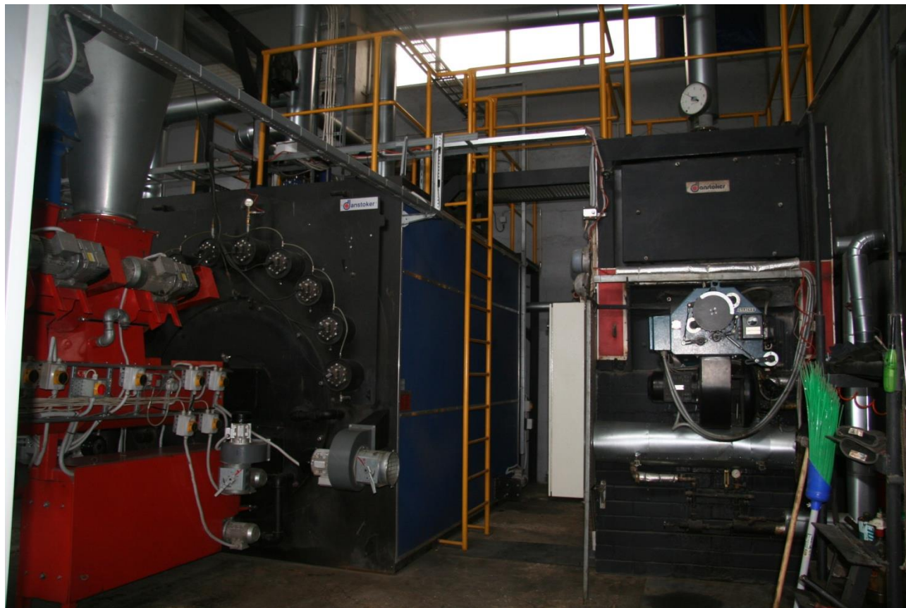
Joonis 26. Danstoker 1,8 MW põhikoormuskatel (vasakul) ja Danstoker Multimaiser 1,23 MW põlevkiviõli katel (paremal) [autori erakogu]
