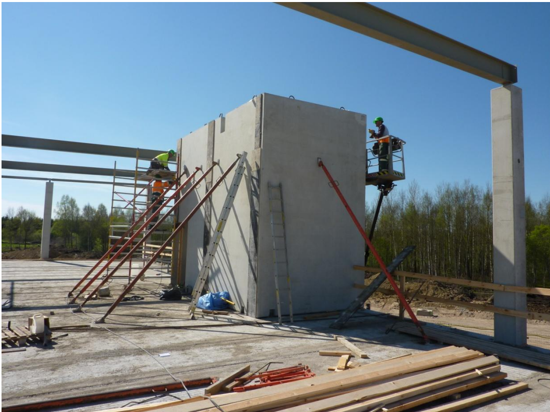
Foto 3. Teise korruse trepikoja seinte montaaž [12]
