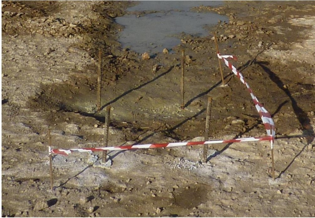
Foto 1. Märgitud kannvundamentide nurgad [12]
