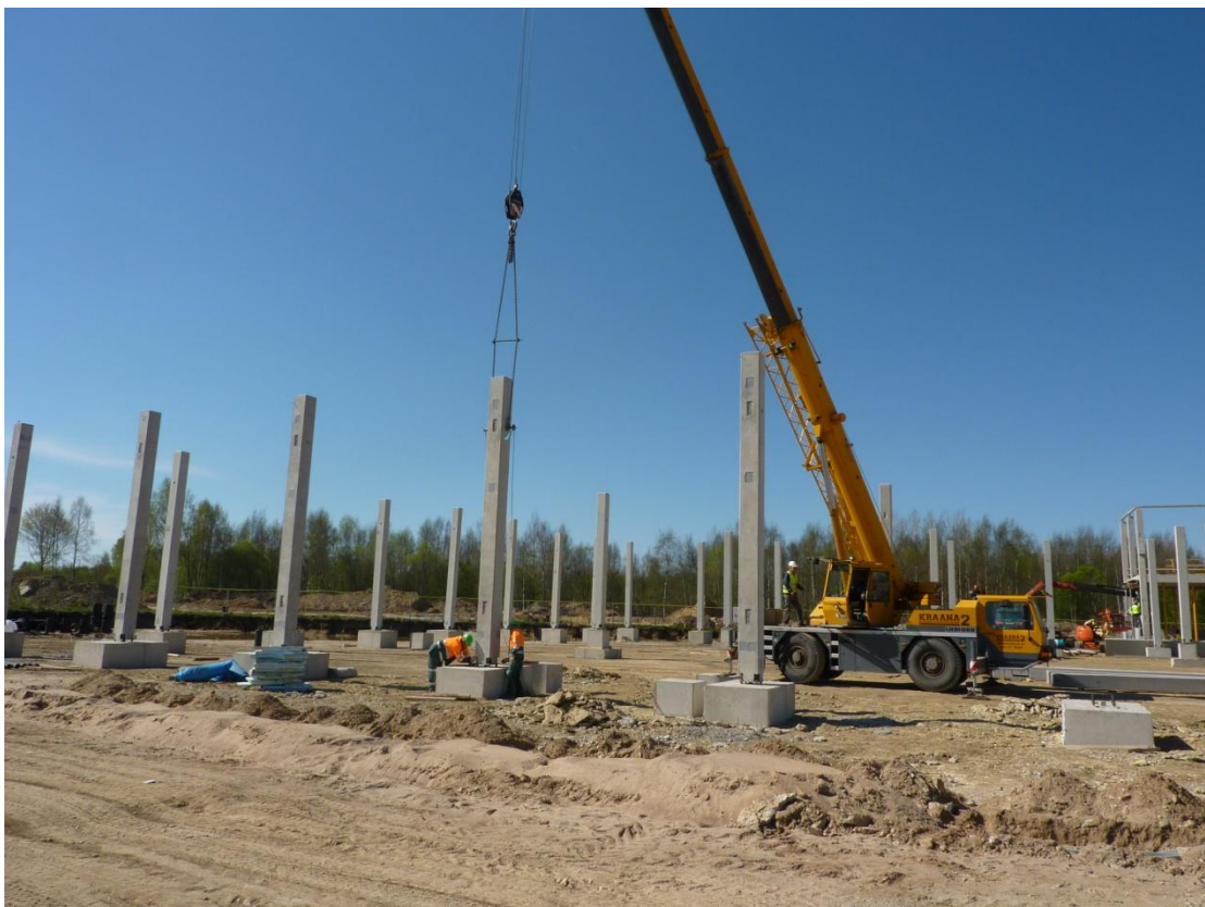
Foto 5. Karkassipostide montaaž [12]
