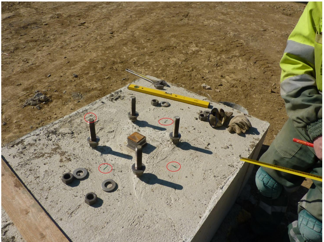
Foto 4. Kannvundamendile märgitud teljeliinid [12]
