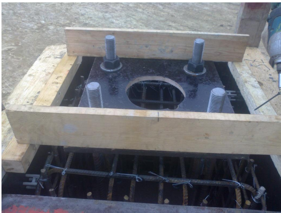
Foto 2. Ankrupoltide paigaldamine kannvundamendile [12]
