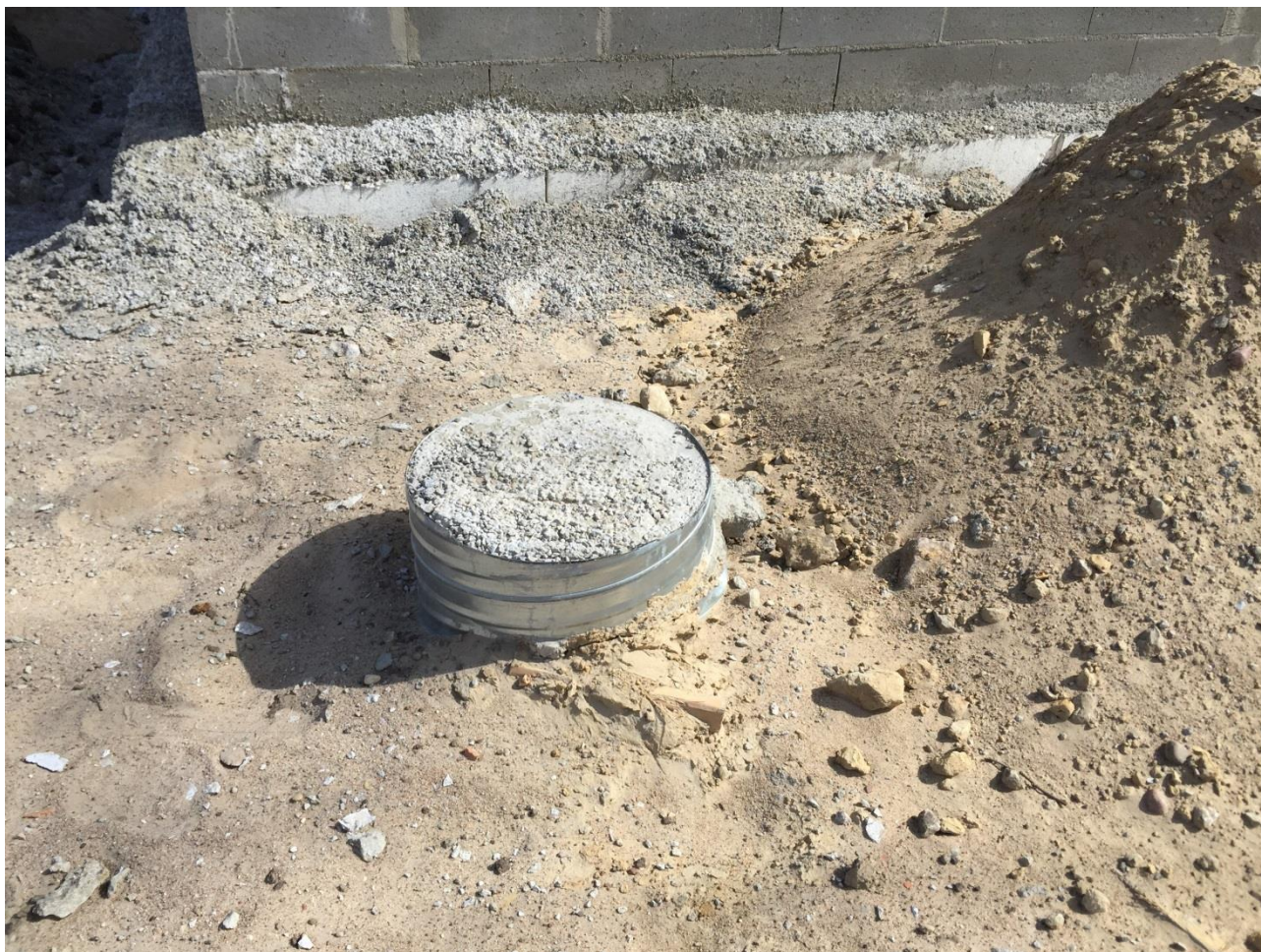
Joonis 15. Rõdu posti kandev vundament
