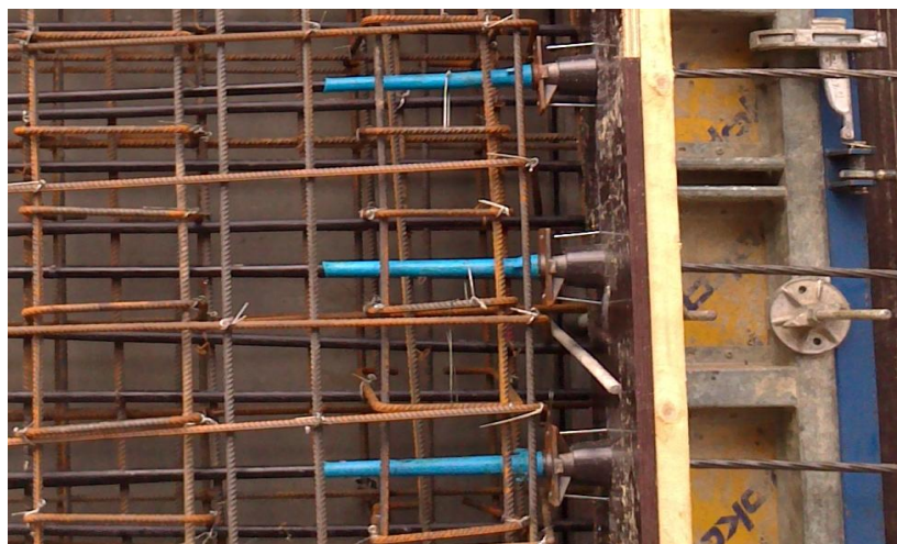
Foto 5. Trossi paigaldamine [Anti Mihkelson erakogu]
