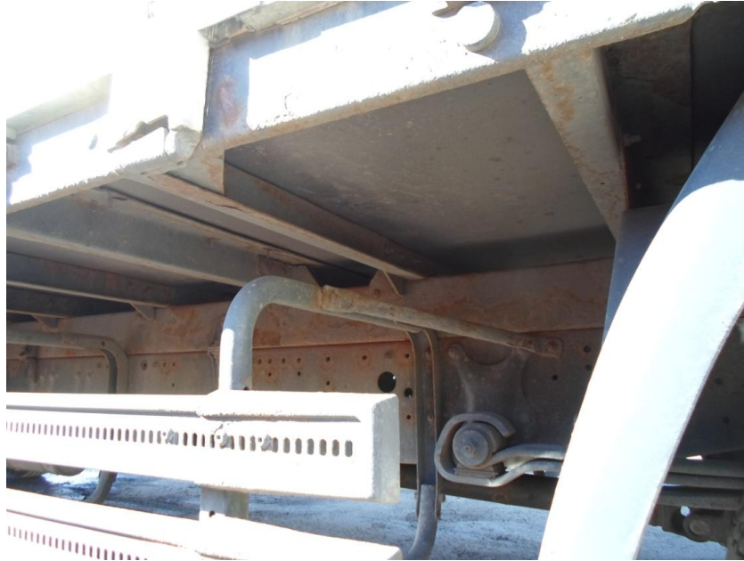
Joonis 6. Vaade aluskonstruktsioonile
