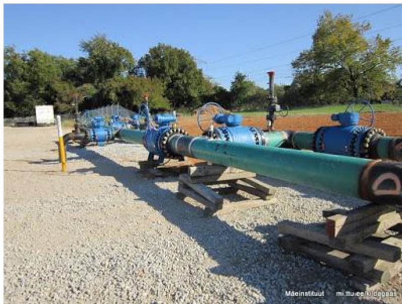
Joonis 11. Surve- ja reguleerimisseadmetega torustik gaasi transpordiks [15]
