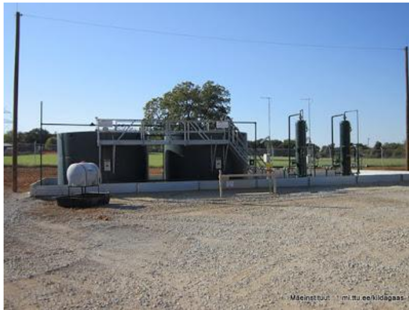
Joonis 12. Gaasi ja liiva eraldaja [15]
