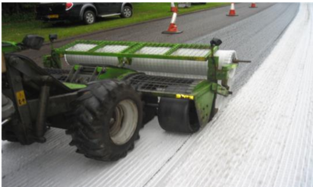
Foto 6. Asfaldivõrgu paigaldus spetsiaalse masinaga [16]
