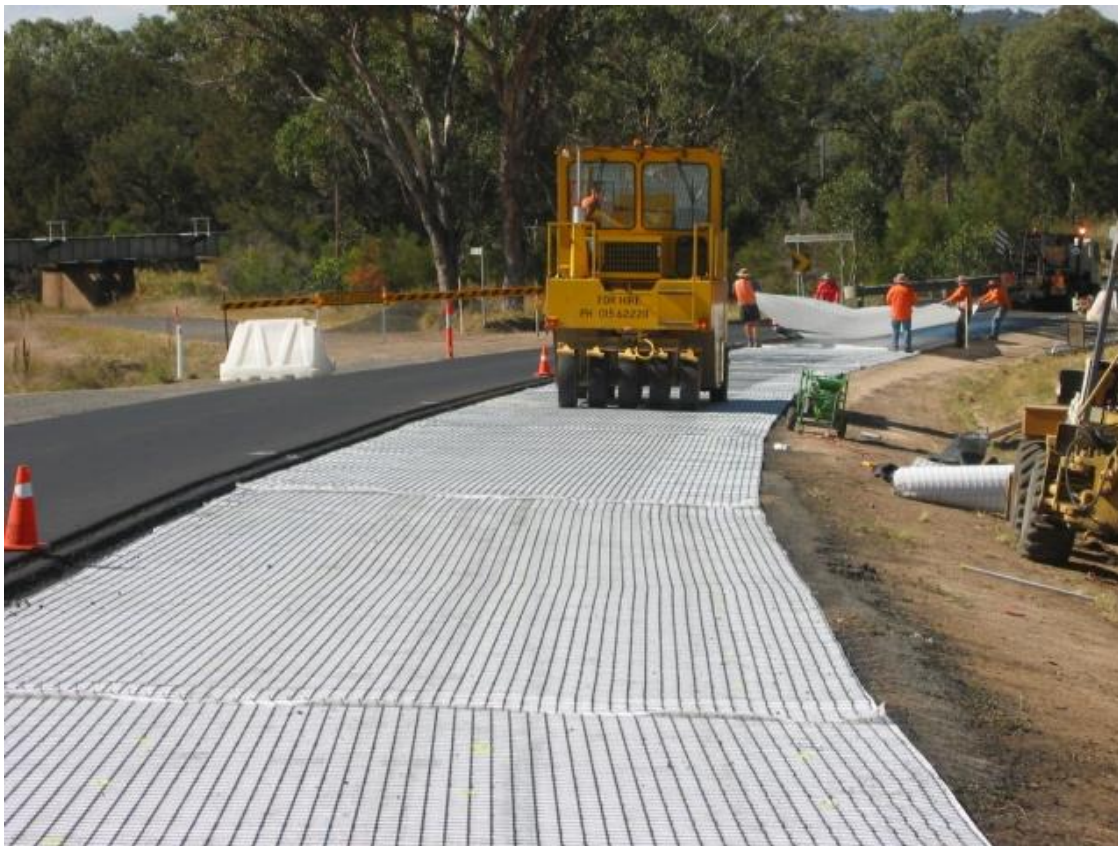
Foto 8. Asfaldivõrgu sirgeks rullimine [16]
