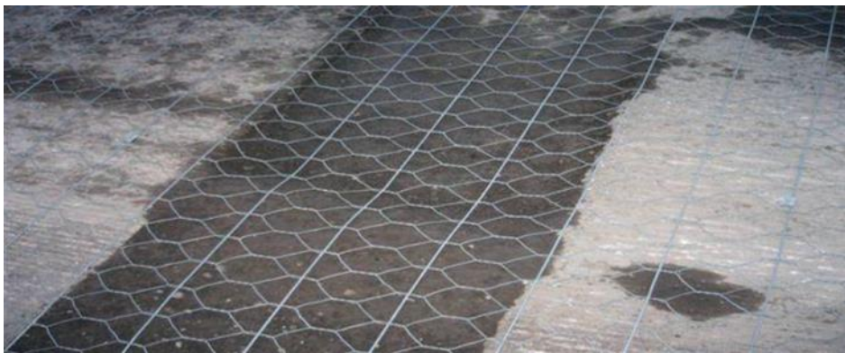
Foto 5. Terasvõrk tugevdusvarrastega [10]
