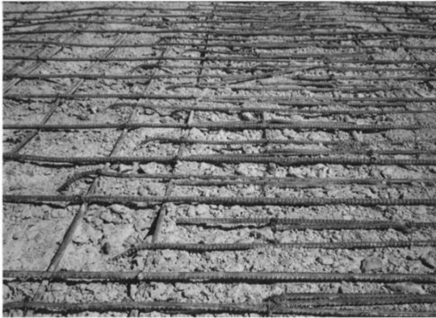
Foto 6. ASR kahjustusega sillateki osaline renoveerimine [7]
