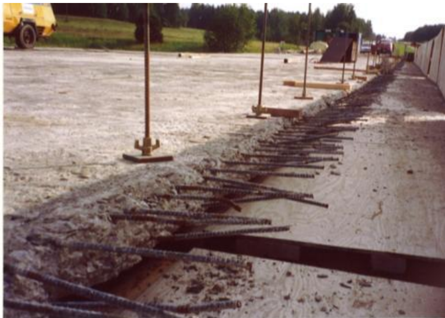
Foto 7. ASR kahjustusest tingitud servaprusside asendamine [7]
