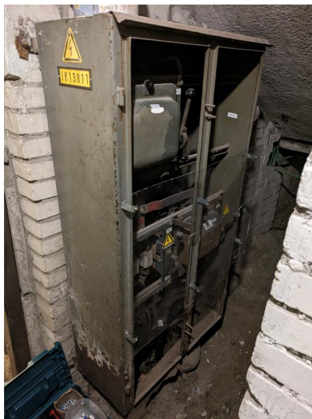
Foto 12. Usteta, kateteta ja läbi roostetanud põhjaga kilp kortermaja ühiskasutatavas keldris
