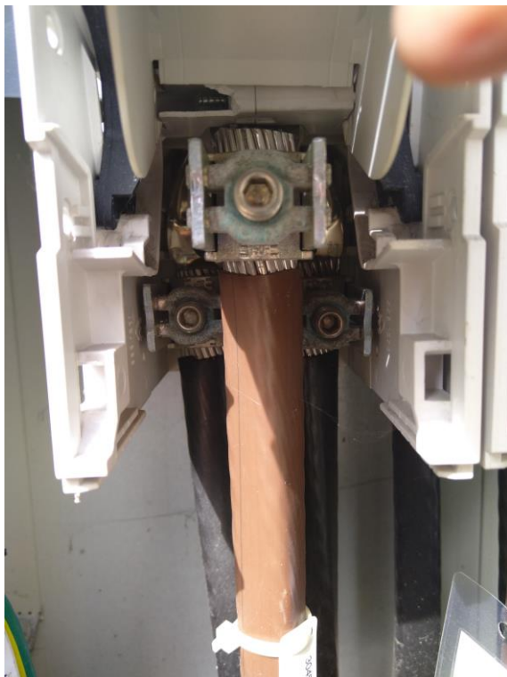
Foto 9. Sektorsoonte ebakorrektsed kontaktühendused JK lüliti klemmidel
