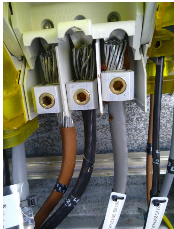
Foto 10. Defektsed kontaktühendused JK lüliti klemmidel
