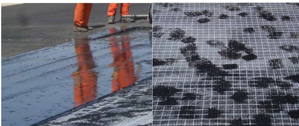
Joonis 16. Tasanduskihile tekkiv peegeldav pind bituumenist viitab sellele, et bituumenit on piisavalt. Peale geotekstiiliga materjali paigaldamist peaks jalajäljed jääma mustaks [8]
