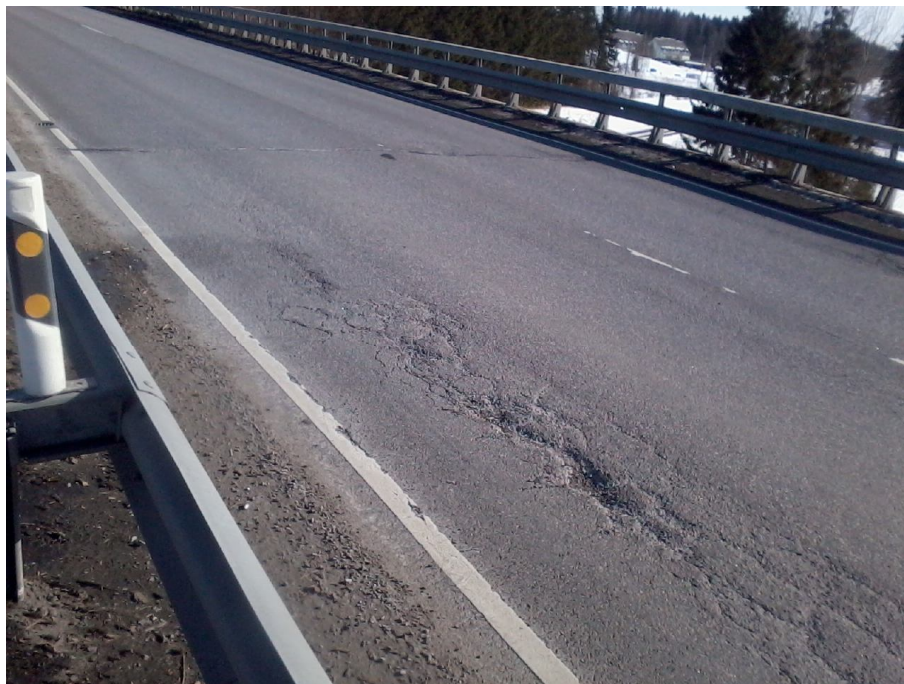
Joonis 2. Võrkpragu Sõmeru viadukti pealesõidul [erakogu]
