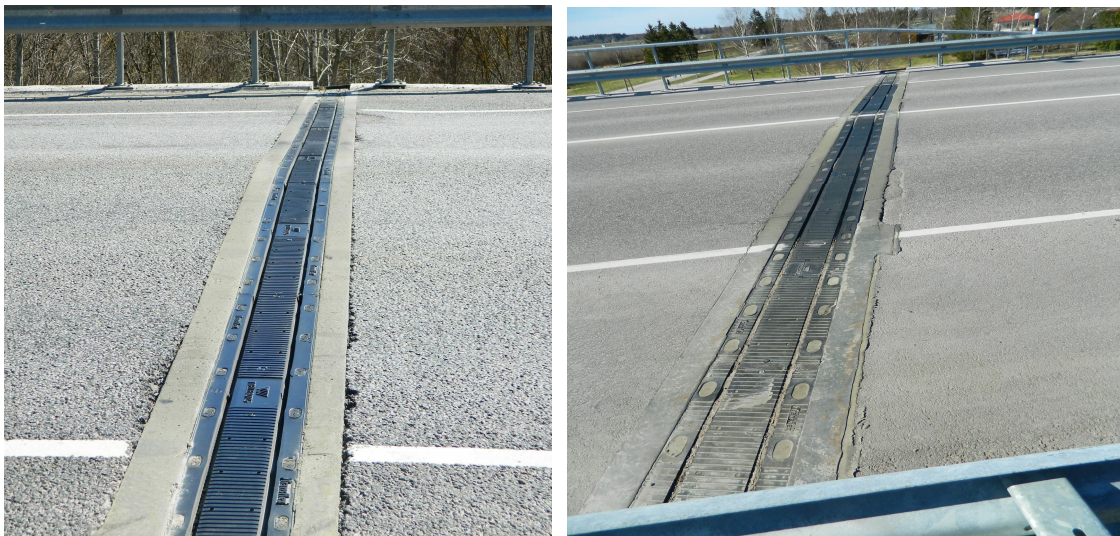
Joonis 43. Ülekatva vuugi defektide arenemine [erakogu]
