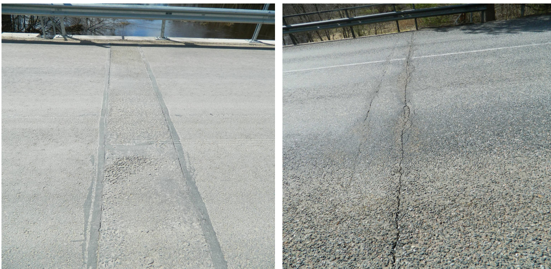
Joonis 42. Täidetud deformatsioonivuukide defektide arenemine [erakogu]
