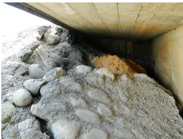
Joonis 47. Pinnase erosioon kaldasamba riigli alt ja tagant [erakogu]
