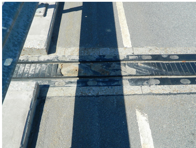
Joonis 44. Lumesahkade poolt lõhutud vuuk [erakogu]
