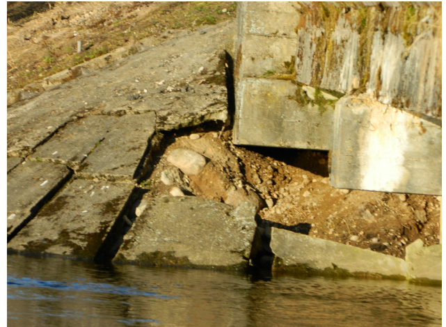
Joonis 46. Pinnase erosioon silla pealesõidul[erakogu]
