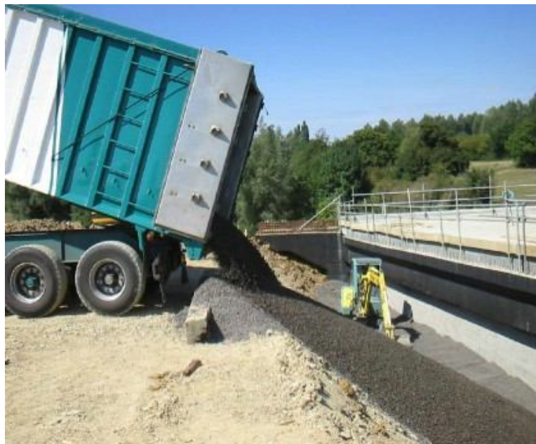
Joonis 21. Kergkruusa kasutamine pealesõidu tagasitäitematerjalina [21]
