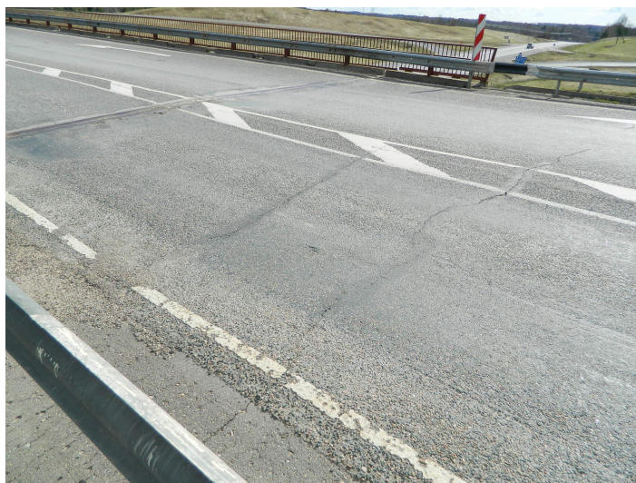
Joonis 45. Katte purunemine pealesõiduplaadi kohal [erakogu]
