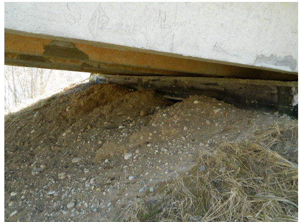
Joonis 47. Pinnase erosioon kaldasamba riigli alt ja tagant [erakogu]
