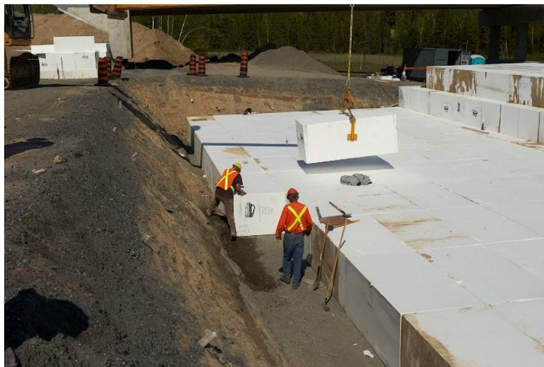
Joonis 19. Silla pealesõidu muldkeha ehitamine EPS-plokkidest [32]
