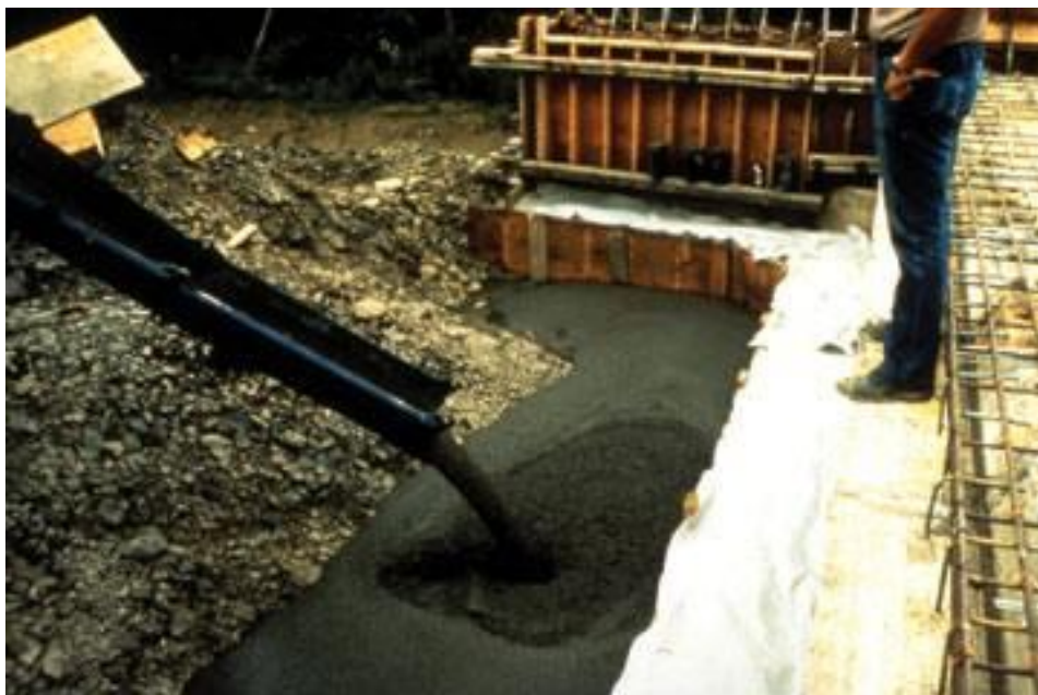
Joonis 18. Kaldasamba tagune tagasitäide vahtbetooniga [14: 13]
