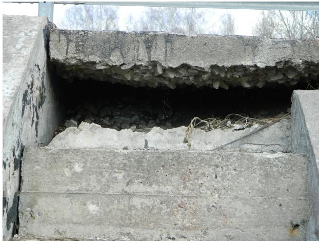
Joonis 46. Pinnase erosioon silla pealesõidul[erakogu]
