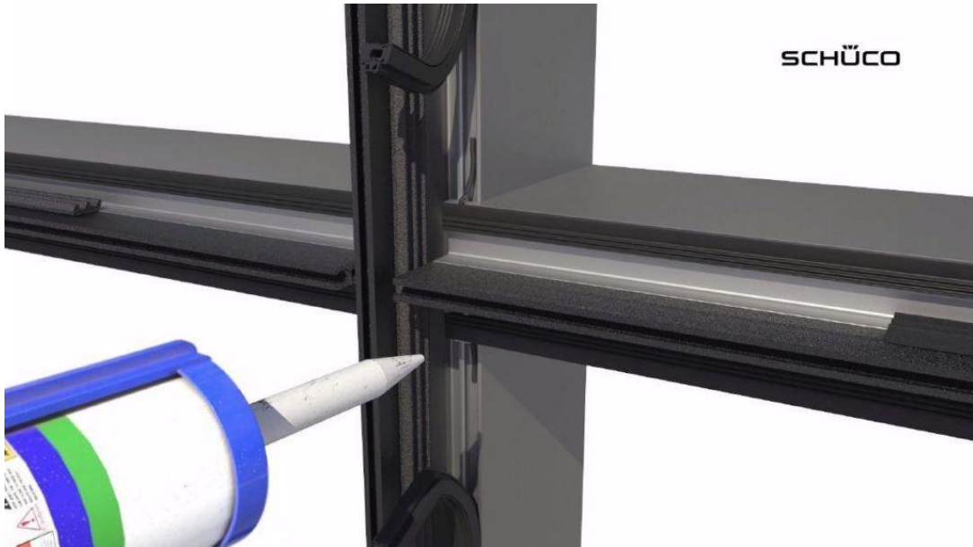
Joonis 13. Klaasfassaadi tihendamine seespools [26]
