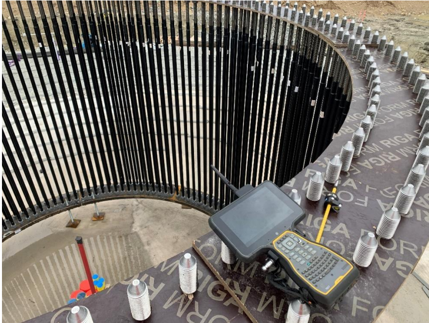
Foto 16. Ankrupoltide kõrguslik märkimine miniprismaga tellingult [13]
