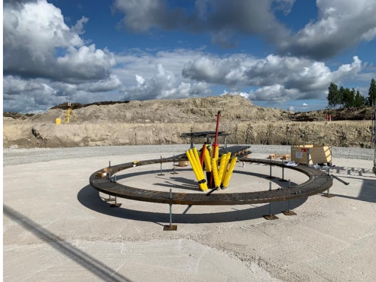
Foto 14. Kõrguslikult ja plaaniliselt märgitud ja teostatud alumine tugirõngas [13]
