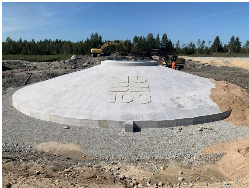
Foto 19. Betoneeritud vundament [13]
