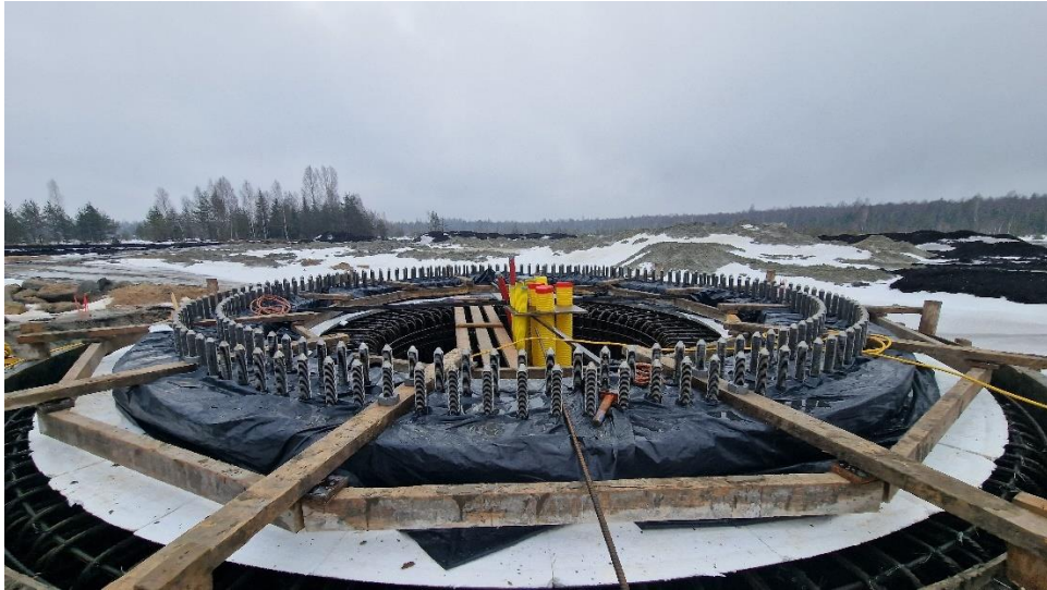
Foto 17. Ankrupoldid, kaablikaitsitorud enne betooni [13]
