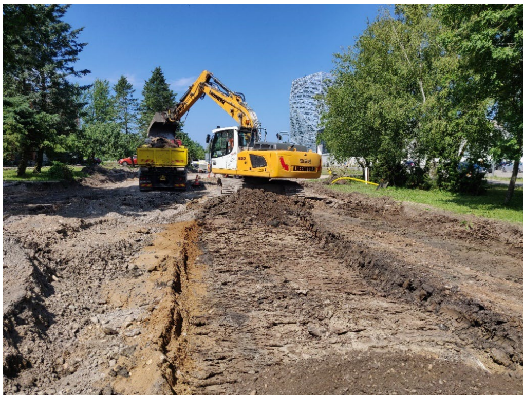
Foto 1. Ehituseks sobimatu pinnase kaevandamine
