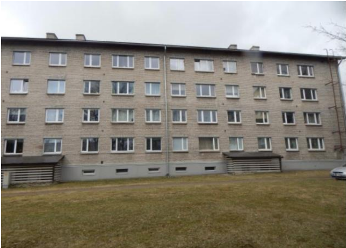
Foto 2. Pepleri tn. 10 renoveerimiseelselt [17]
