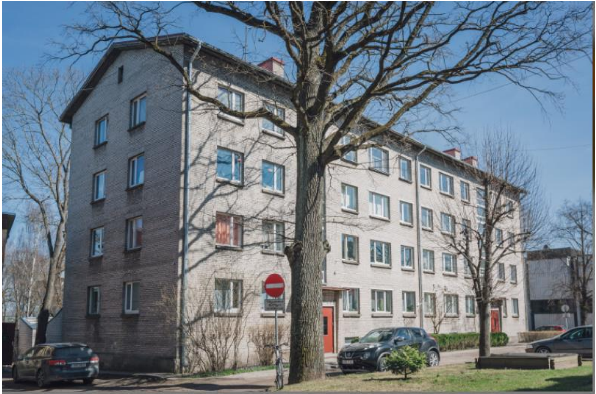
Foto 1. Tiigi tn. 3 renoveerimiseelselt [5]
