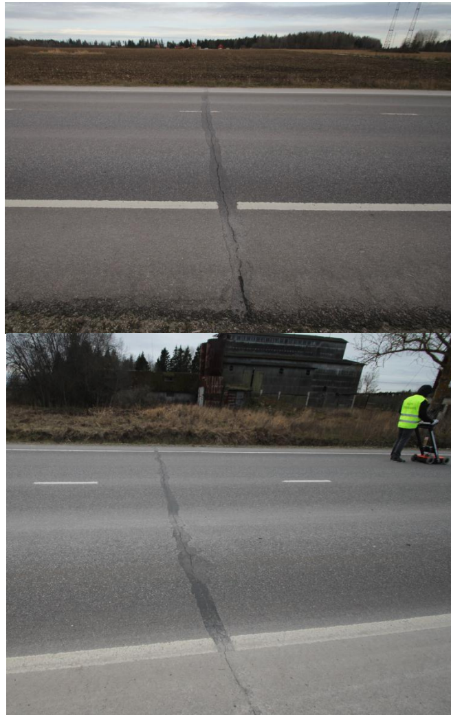
Foto 10,11. Esimene ja teine põikpragu vaadeldavas piirkonnas. [26: 9]
