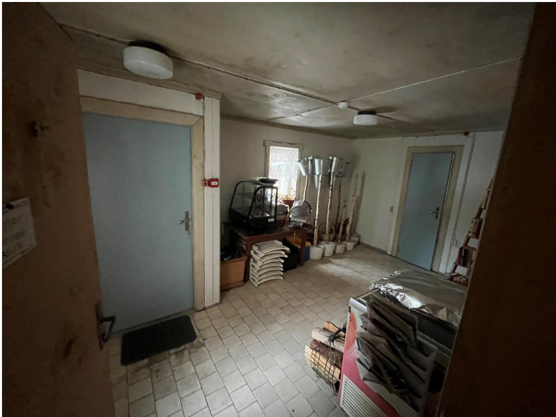
Foto 11. Vabrikuväljak 6 veranda ja tualetid
