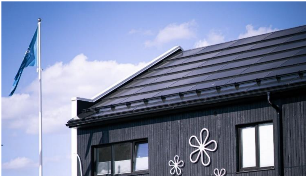
Pilt 25. Nähtamatu päikesepaneelide näidis. Solarstone OÜ. Pilt internetist.
