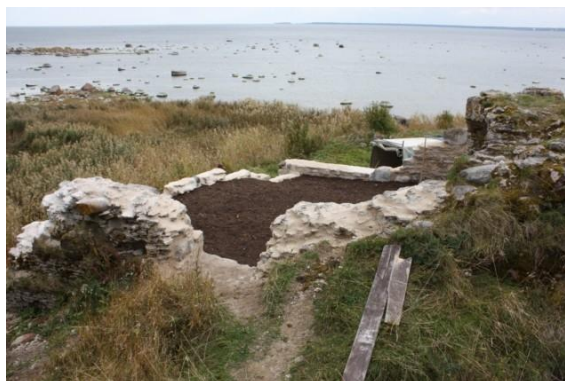
Pilt 22. Toolse linnusevaremete konserveerimine (keldriruumi võlvlagi). Foto: J. Vali 15.09.2010 [5].
