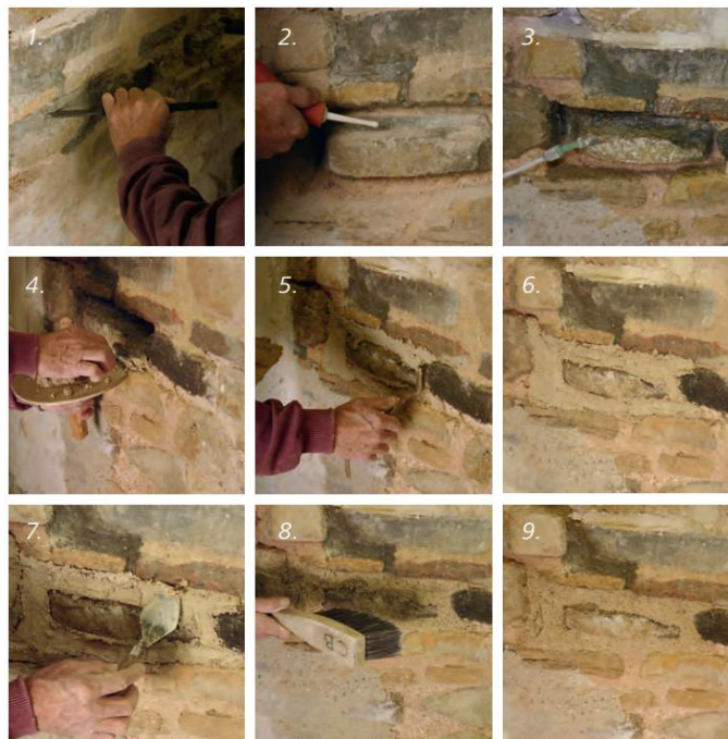
Pilt 21. Peamised etapid müüride puhastamisel [13].
