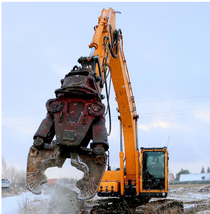
Joonis 5. Lammutustööl kasutatav betooni pulbristaja [15]
