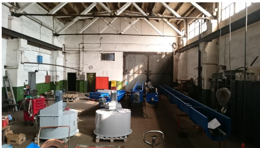
Sele 10. Montaažitöid teostatakse I tootmisruumis
