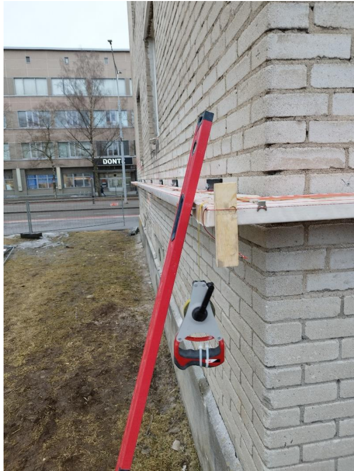
Foto 5. Taridetailide ja sidepuude paigaldus
