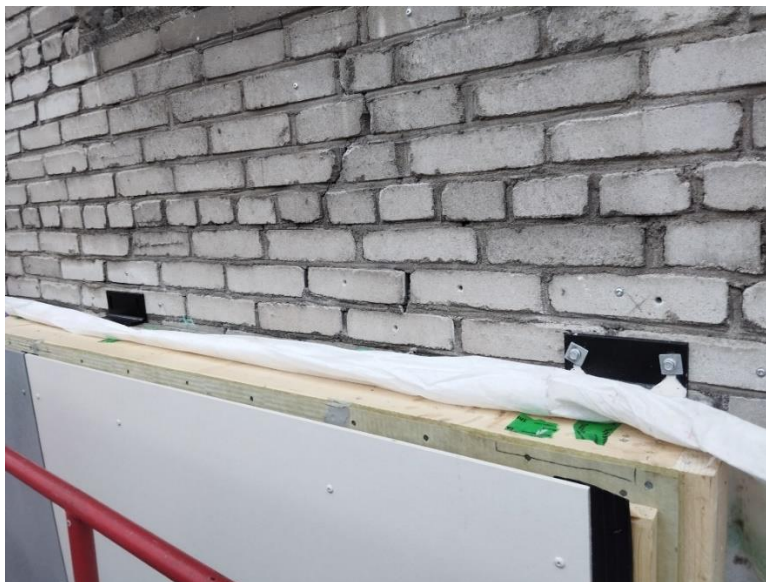
Foto 7. Tellisvoodri saneerimine ning TD2 paigaldus
