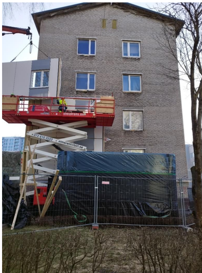
Foto 8. Otsaseinte fassaadipaneelide paigaldus
