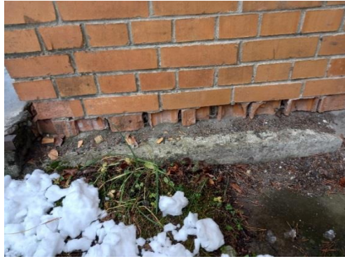
Foto 6. Hoone trepikoja vundament
