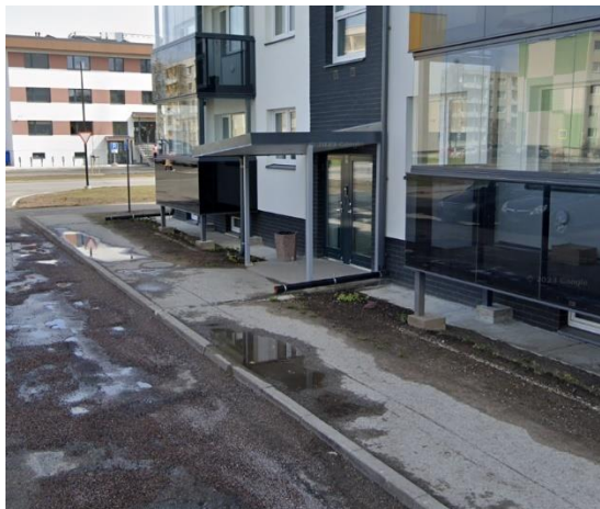
Foto 2. Koondise tn 15 kergliiklustee defektid
