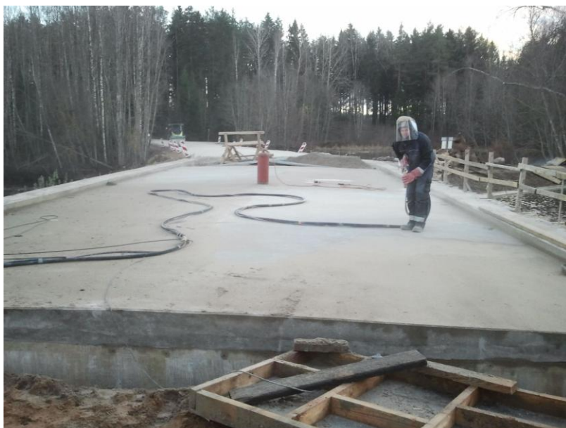
Joonis 18. Liivapritsitööd Leevaku sillal [erakogu]
