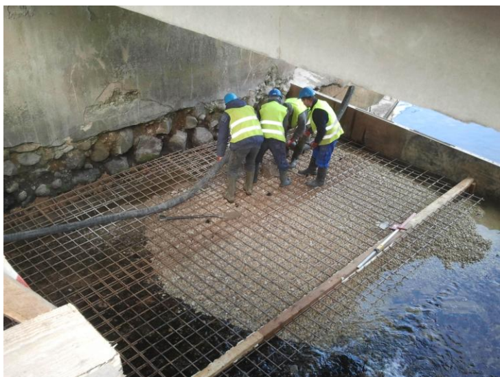
Joonis 13. Betoneerimistööd Leevaku sillal [erakogu]
