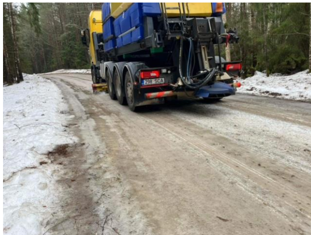
Joonis 16. Hooldeauto teostamas karestamist tappteraga
