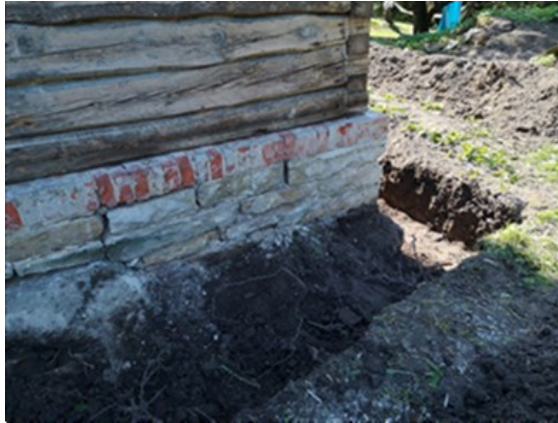
Joonis 6. Rehielamu vundamendi ja välisseina nurk (Autori erakogu)
