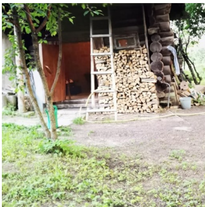
Joonis 9. Ait- sauna välisseina nurgaseotis (Autori erakogu)
