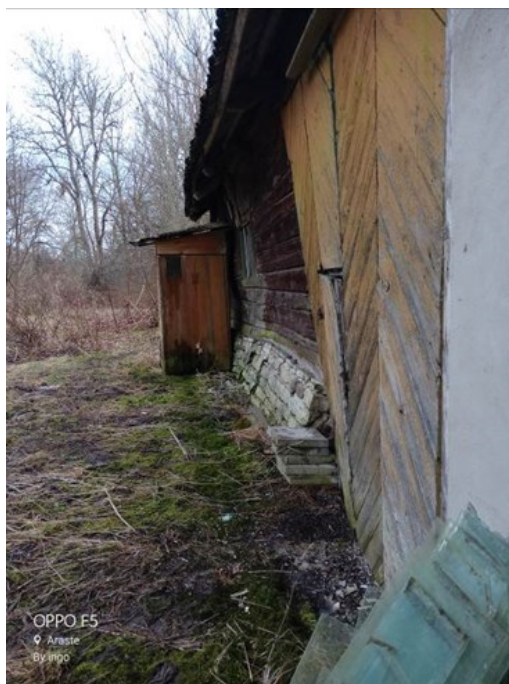
Joonis 8. Hoone mitteköetava osa varisemisohtlik välissein (Autori erakogu)
