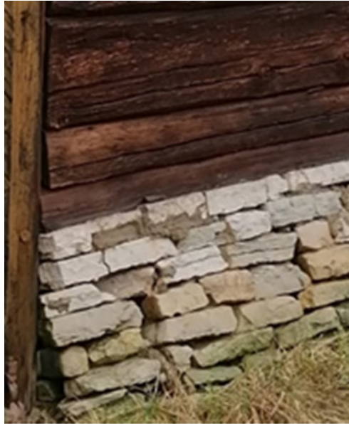
Joonis 4. Kütteta hooneosa vundament (Autori erakogu)
