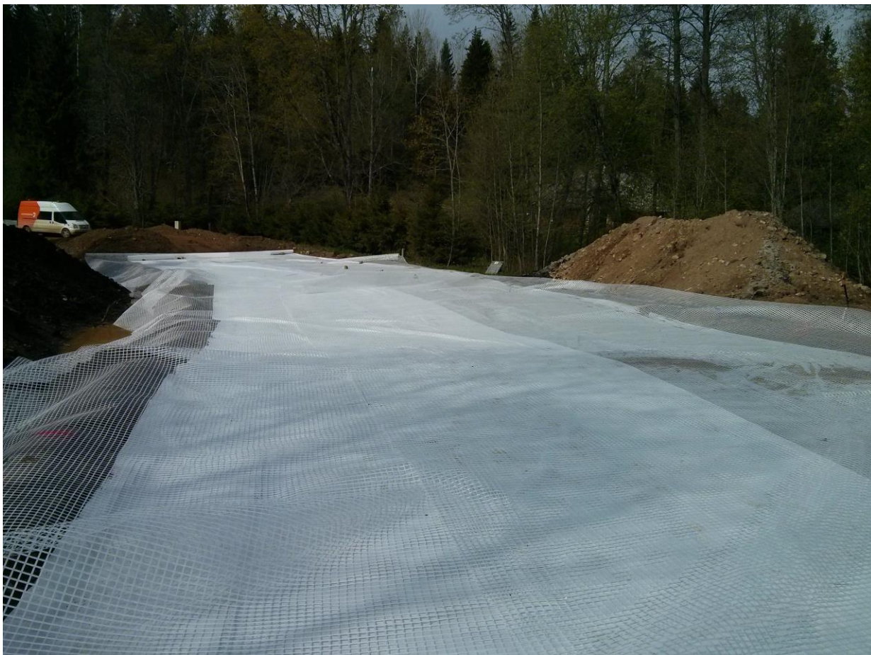
Foto 2. Geotekstiili ja geovõrgu paigaldamine [Erakogu]
