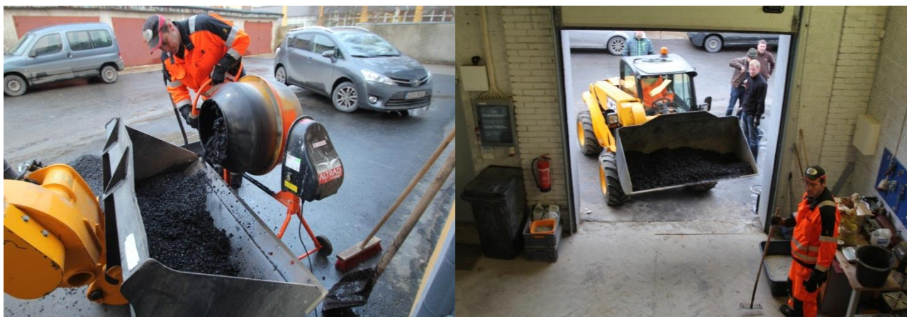
Fotod 29 ja 30. Mustsegu valmistamine [1]
