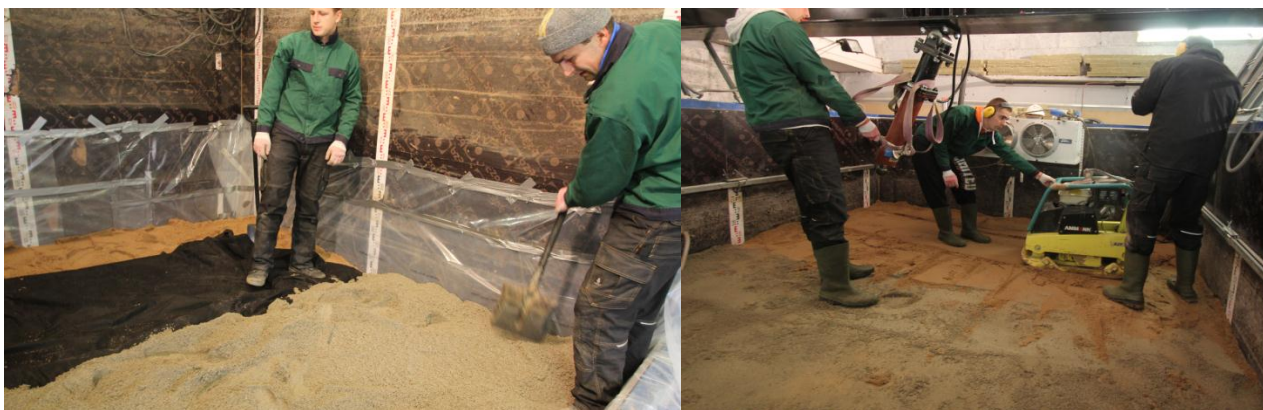
Fotod 9 ja 10. Materjalide paigaldamine, eraldamine ning hüdroisolatsioonikiht; vibroplaadiga tihendamine [1]
