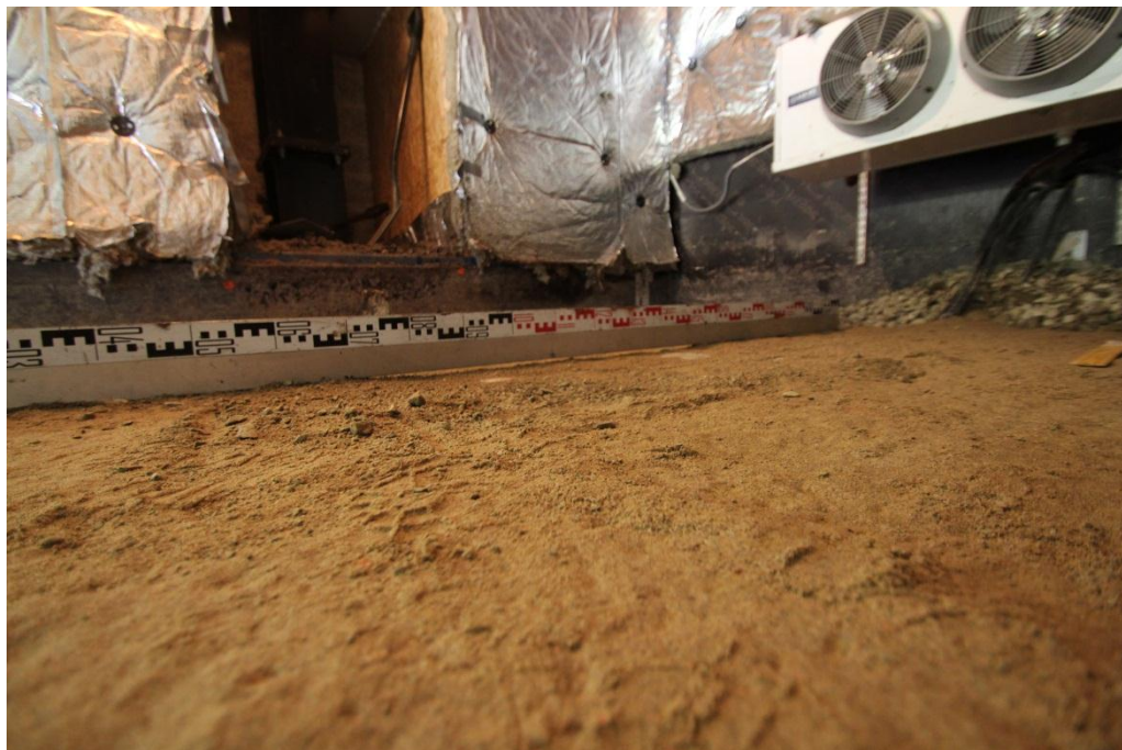
Foto 39. Vajum paesõelmetest drenkihil [1]
