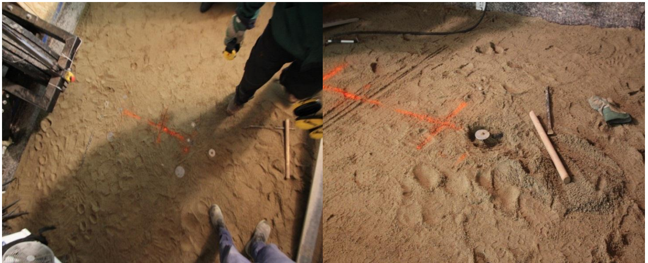
Fotod 16 ja 17. Andurite paigutus drenkihis; vajumianduri paigaldamine [1]
