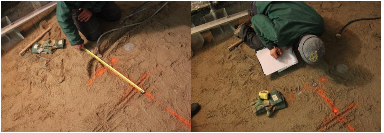
Fotod 13 ja 14. Pingeandurite paigaldamine [1]
