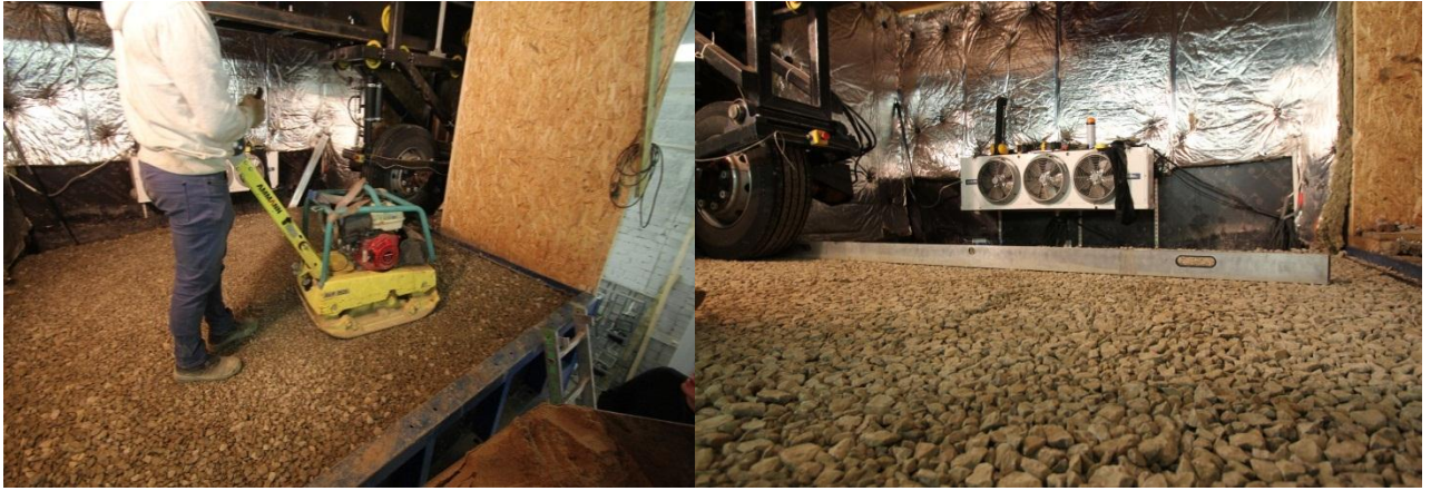
Fotod 18 ja 19. Killustikaluse tihendamine; loodimine [1]
