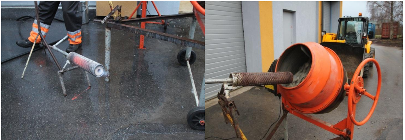
Fotod 21 ja 22. Gaasipõleti ja killustiku kuumutamine [1]
