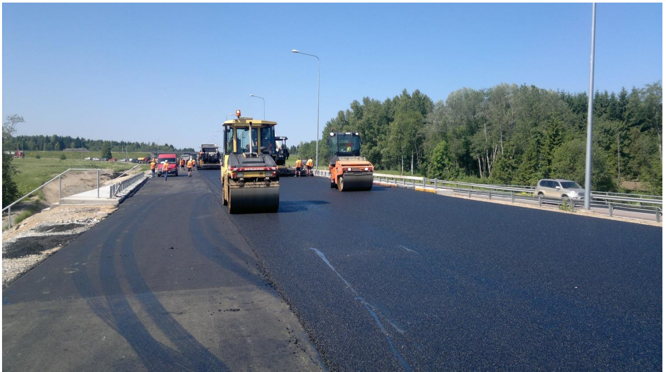
Foto 2. Kaks asfaldi rulli tihendamas asfaltsegust kulumiskihti [4]
