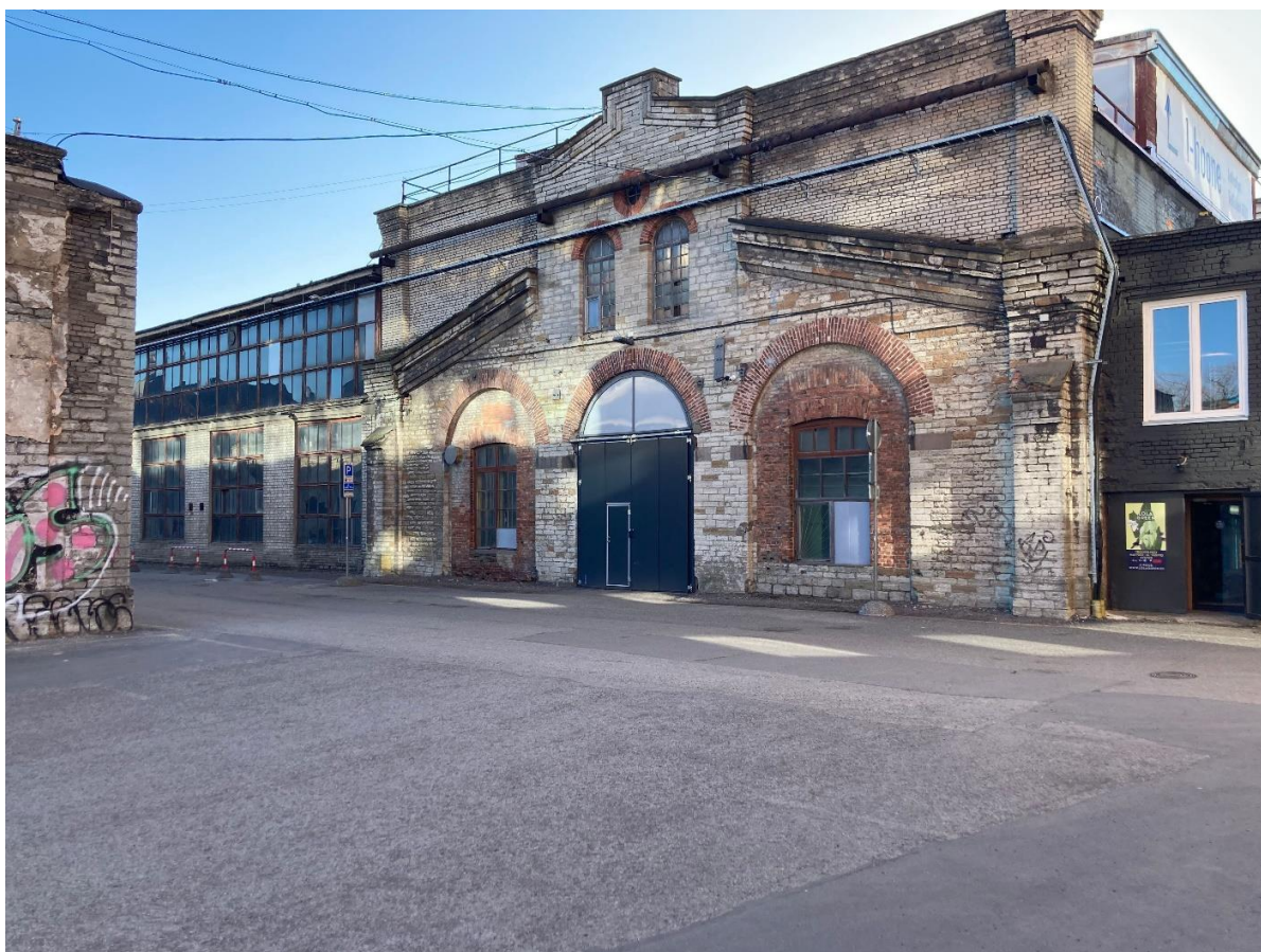
Joonis 2. Vaade M-hoone väärtuslikule päekivist fassaadiosale
