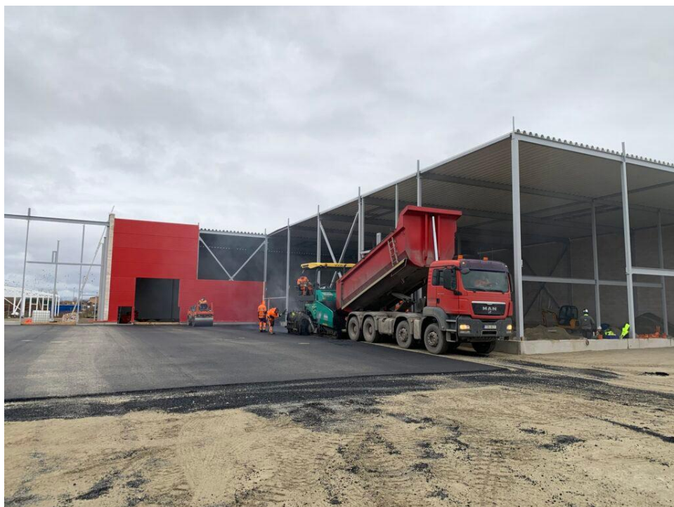
Joonis 12. Objekt Nuia 16/18 teedehituse protsess [19]
