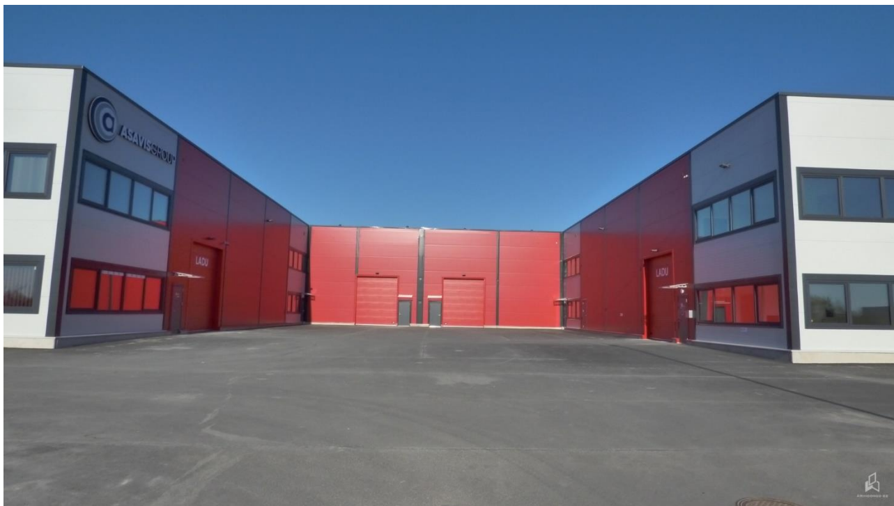
Joonis 3. Ehitatud objekt Nuia 16/18 [3]
