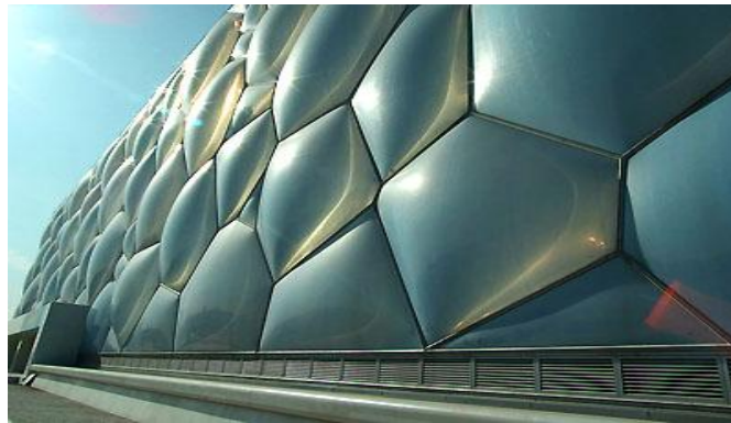
Joonis 10. Beijngi rahvusvaheline veekeskus, mille katusepaneelid on tehtud ETFE-st. [22]
