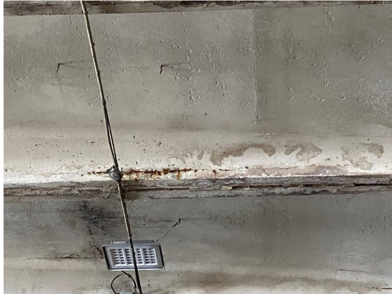
Foto 20. Sarruse korrodeerumine
