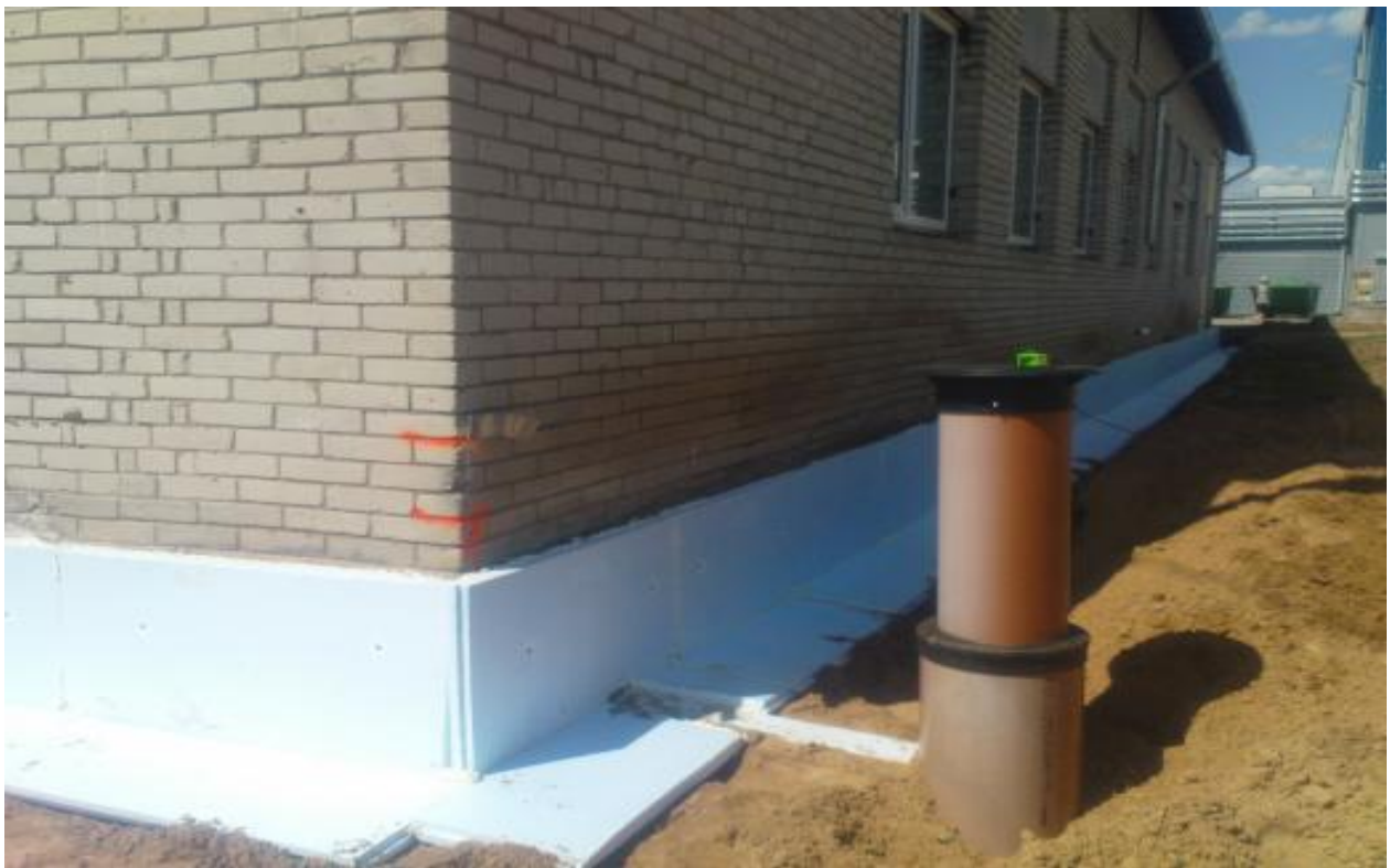
Joonis 3. Elumaja sadevee ja drenaazi süsteem
