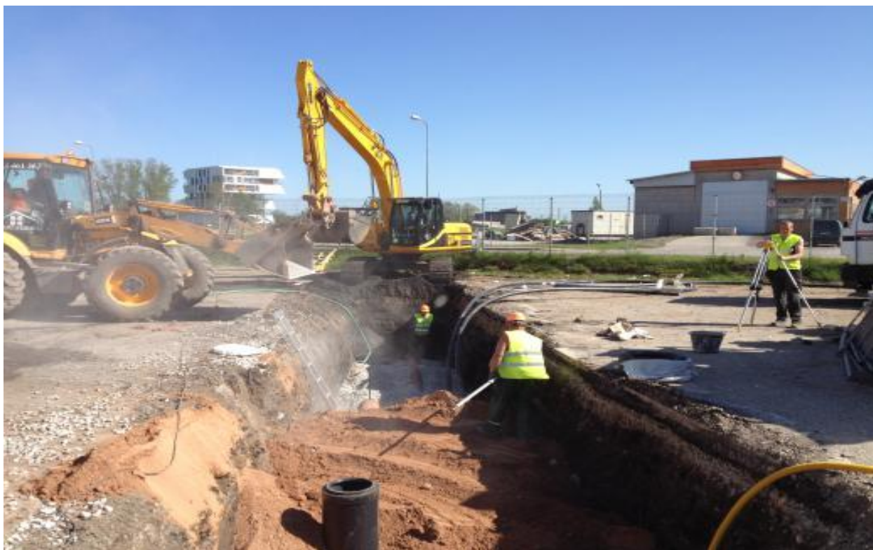
Joonis 2 ESPAK AS Trassitööd, Tartu
