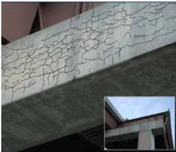
Foto 30. Tala pragunemine sekundaarse etringiidi tekke tõttu [32]
