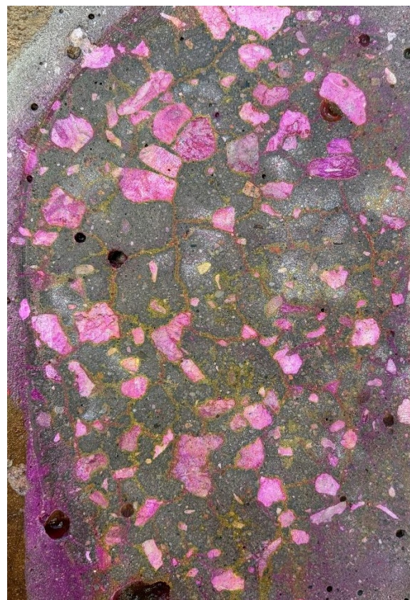
Foto 42. Roosa värvaine jäljed betoonpostil, mis viitavad arenenud ASR-le
