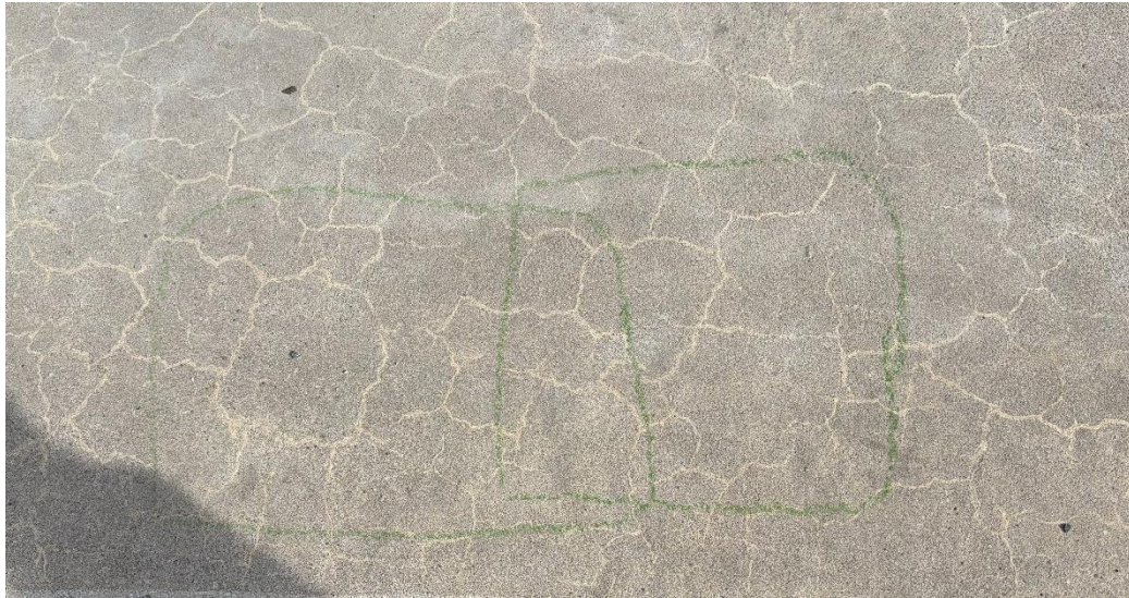
Foto 48. Objekt 3 servaprussi ülemise osa uuritav pind, millel täheldati võrkpragunemist
