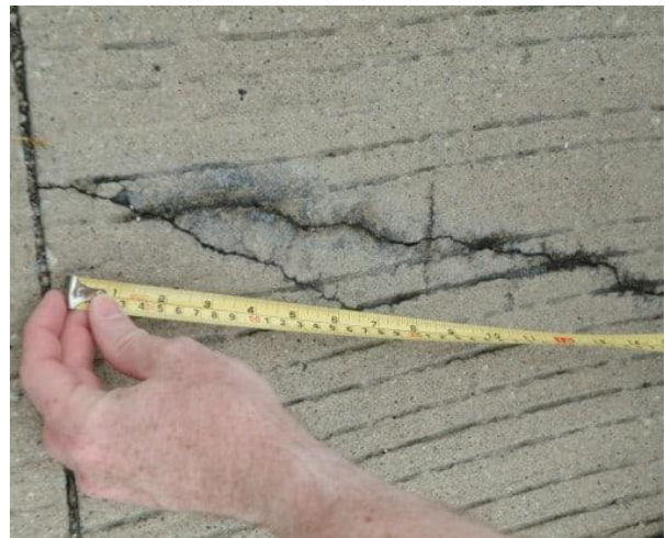
Foto 31. Etringiidi tekest põhjustatud pragunemine [32]
