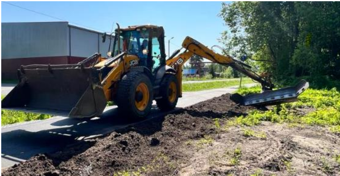
Foto 2. Kopplaadur lisatarvikuga roop mulda planeerimas
