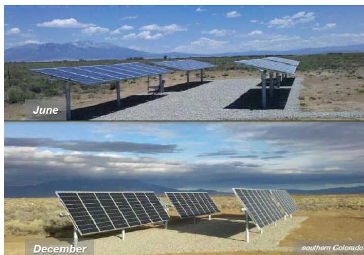
Sele 18. Päikesepaneelide asend suvel ja talvel samal kellaajal. Colorado osariik, USA.
