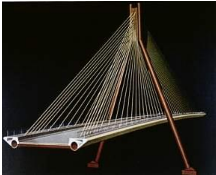
Joonis 7.6 Fibriga tugevdatud plastmaatriksiga komposiitmaterjalist loodud sild [11]
