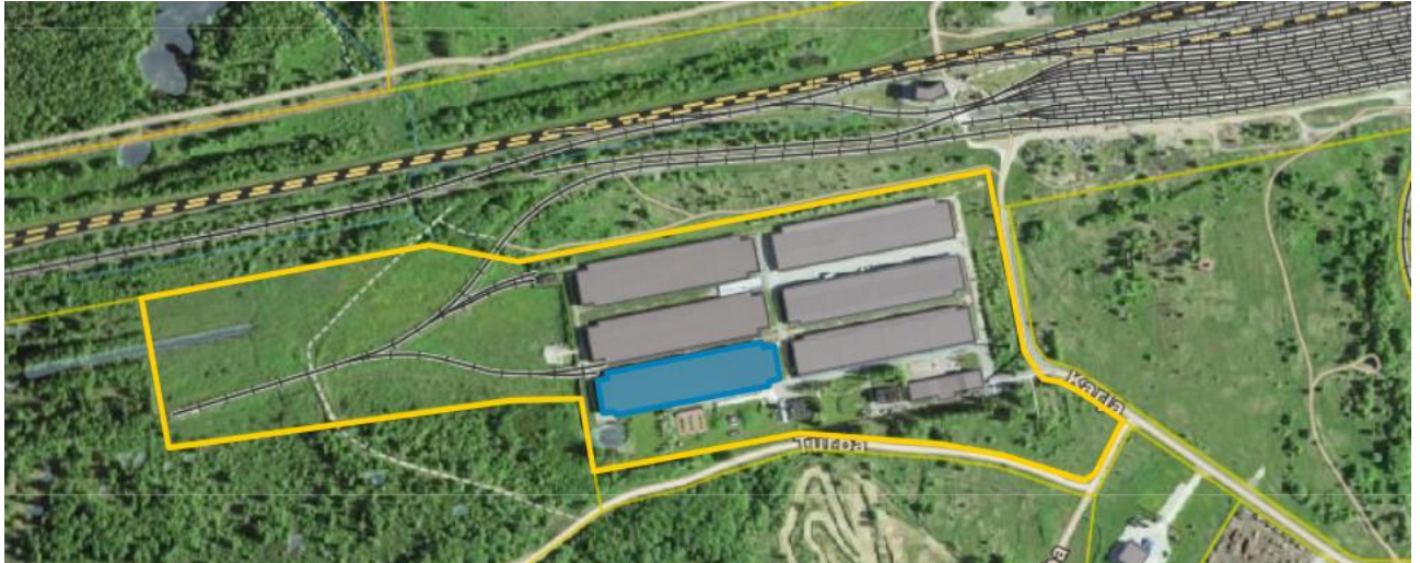
Foto 2. Raudteeühendus objekti ja renoveeritava hoonega [2]
