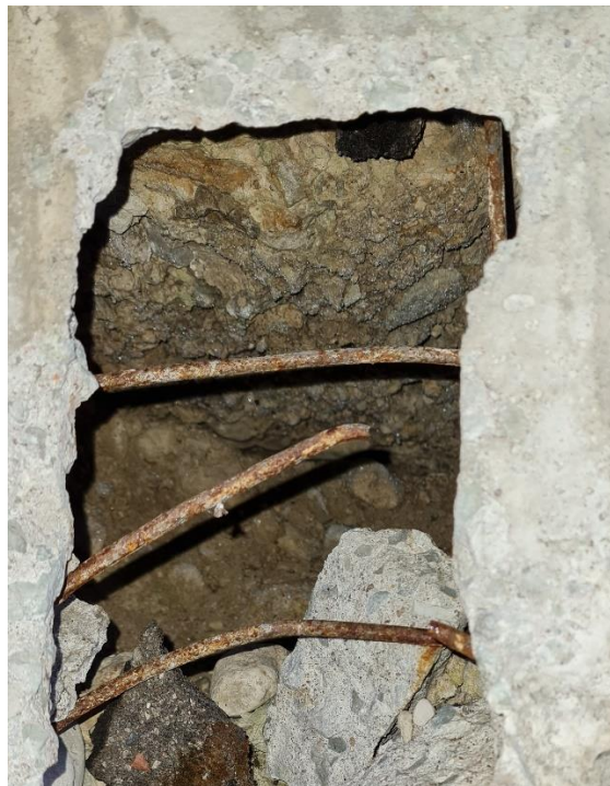
Foto 7. Autoestakaadi puuritud auk (Autori foto)
