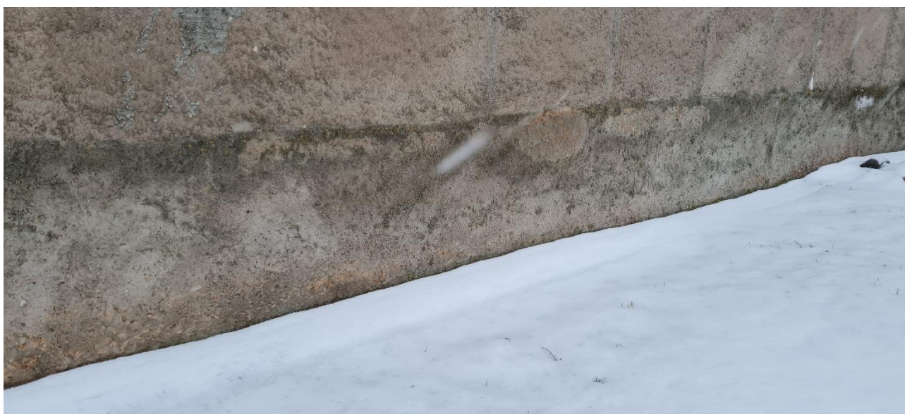
Foto 3. Hoone vundament (Autori foto)
