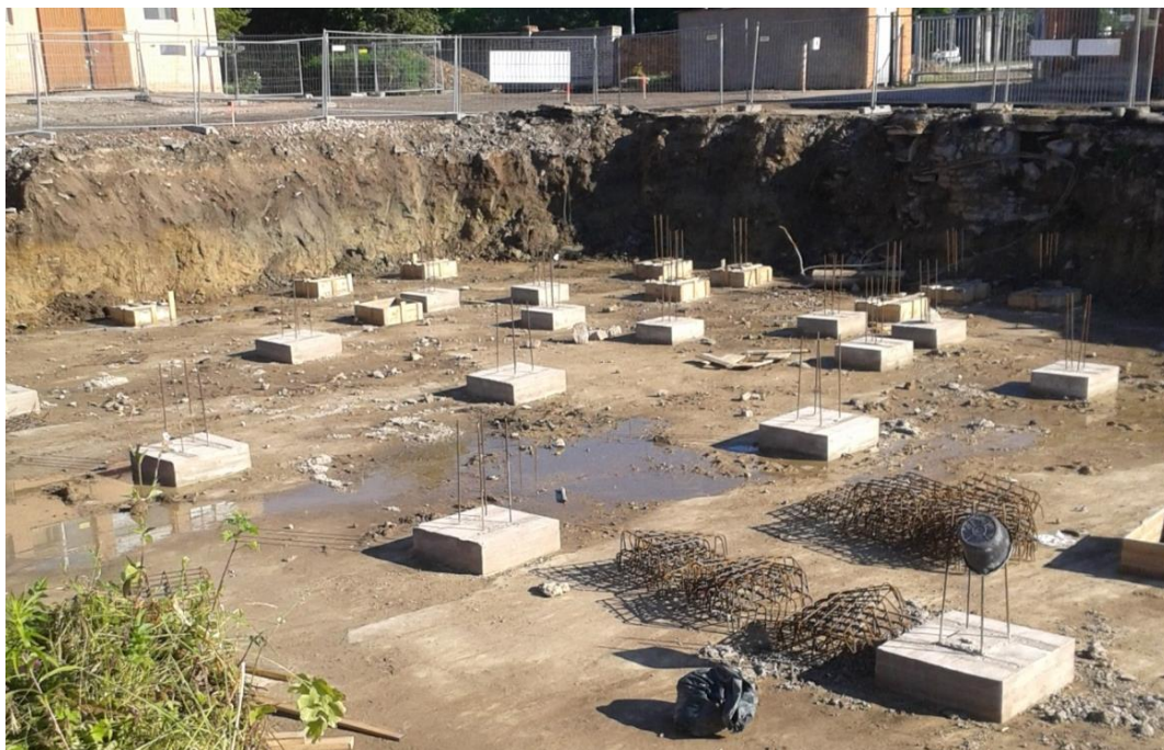
Foto 2. Valmistatud vundamenditaldmikud (autori foto)
