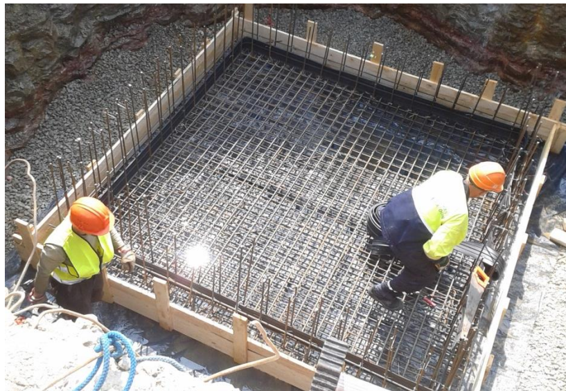
Foto 8. Sumba põrandaplaadi raketise armeerimine (autori foto)
