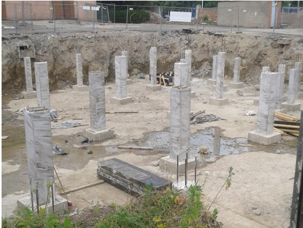
Foto 3. Valmistatud vundamendipostid (autori foto)
