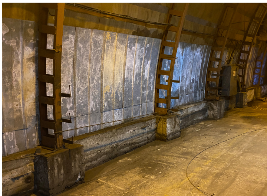
Foto 19. Vundament ja kandekonstruktsioon
