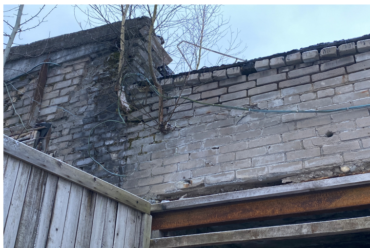
Foto 12. varisemisohtlik piirdetarind
