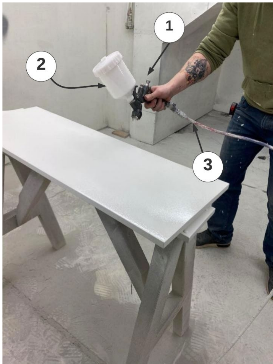
Joonis 22. Värvimise protsess: 1 – Värvipüstol Walther Pilot III, 2 – värvipaak, 3 – suruõhuvoolik
