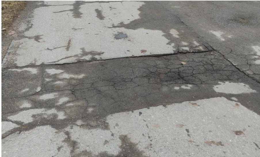
Foto 8. Sompas linnaosa, Betooni tänava lapitud asfaltbetooni vajumine
