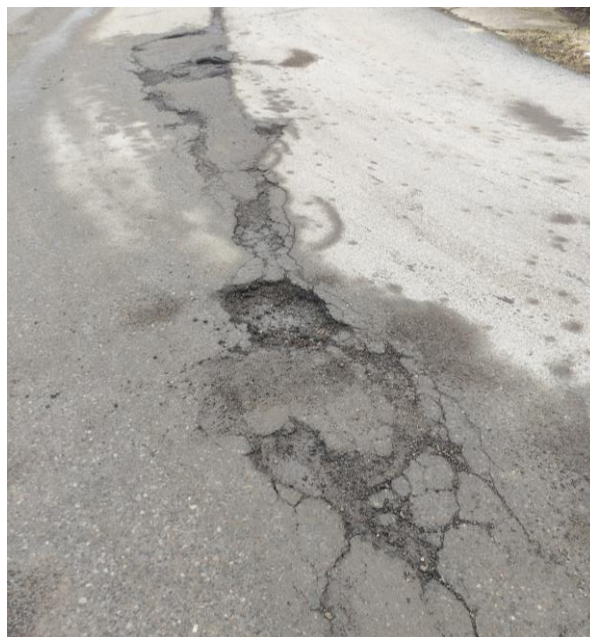
Foto 16. Kvartalsisese tänava defektid
