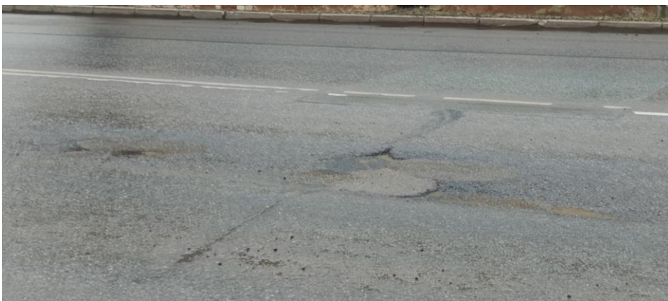
Foto 22. Järveküla tänava põikproad ja roopad
